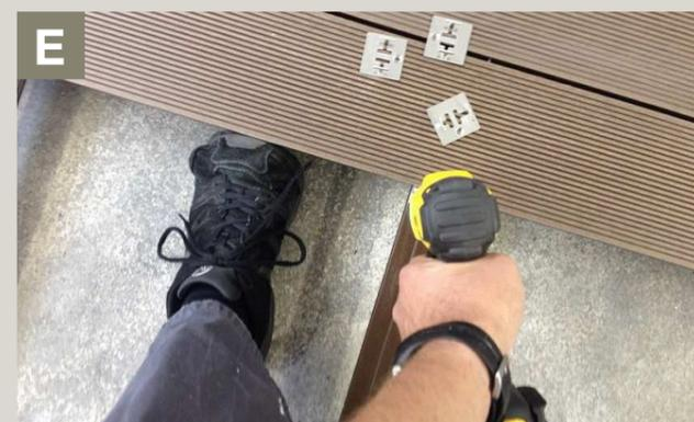
Verwenden Sie zum Spannen nie Schraubzwingen oder Spannwerkzeuge. Einfach mit dem Fuss anpressen und den Klipp entsprechen vorbohren (2.5 mm). Eine zu hohe Spannung kann zu einer Deformation der UK führen und den Boden anheben.
