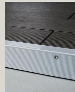
**Frontabschluss mit Aluwinkel** wird empfohlen bei begehbaren Bereichen wie Treppenstufen, Kanten oder Absätzen.
